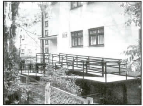
Podjazd dla niepełnosprawnych. Fot. J. Roik
